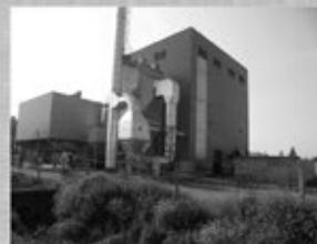
Likaenergo d.o.o., Udbina, snage 0.959 MW električne i 4.1 MW toplinske: proizvodnja struje iz biomase (iz kore) - na primjeru ORC procesa, a toplinsku energiju koriste za proizvodnju drvenih peleta
