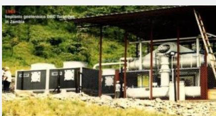
**1988 – 200 kW<sub>el</sub> ORC geotermalno postrojenje u Zambiji**
